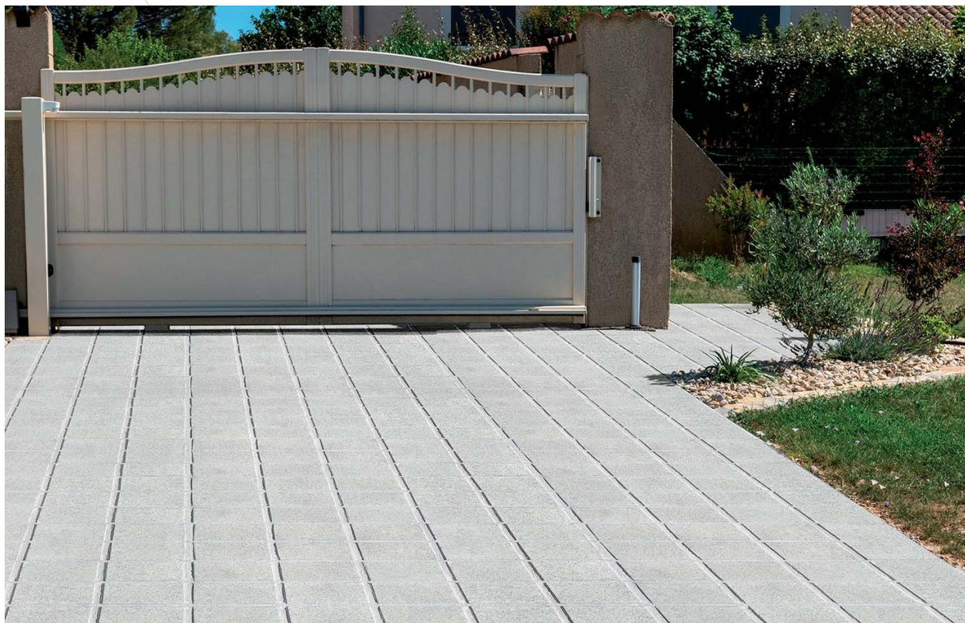
Le pavé drainant Carus Fabemi à écarteurs intégrés répond parfaitement aux contraintes urbaines et environnementales d'infiltration des eaux de pluie. Les ergots distanceurs intégrés sont conformes aux recommandations contenues dans le DP136 du Guide de mise en œuvre des revêtements drainants préfabriqués en béton (V3-sept2020).
